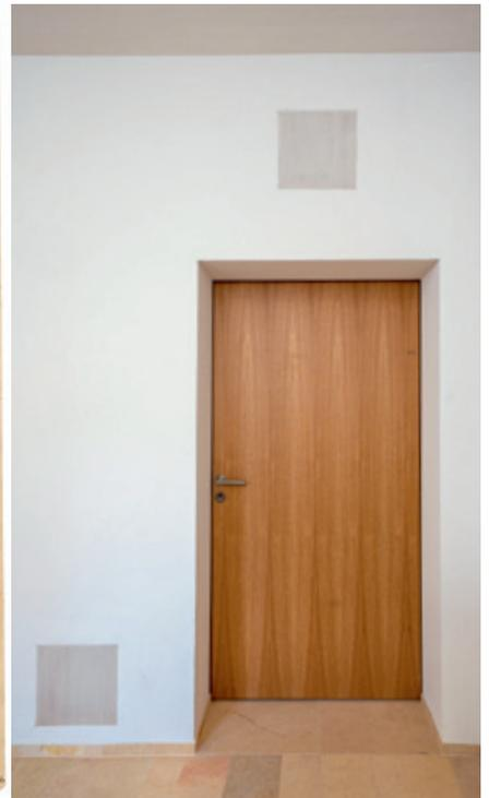
Abb. 19 und 20: Plan zur Einrichtung im Tobhaus von Josef Unger; im neuen Sommerhaus Kennzeichnung der früheren Lüftungsklappe über den Türen und einer Klappe zum Entleeren der Notdurfteimer.
