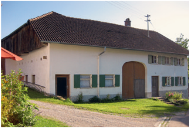
Abb. 28: Ansicht von Norden 2010, nach Verputzen der Ostfassade.
