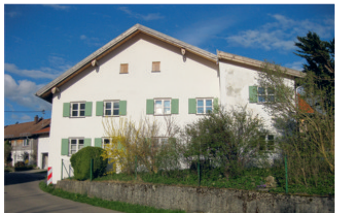
Abb. 35: Ansicht von Westen 2015.
