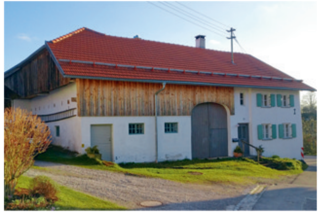
Abb. 29: Ansicht von Norden nach der Sanierung 2015.
