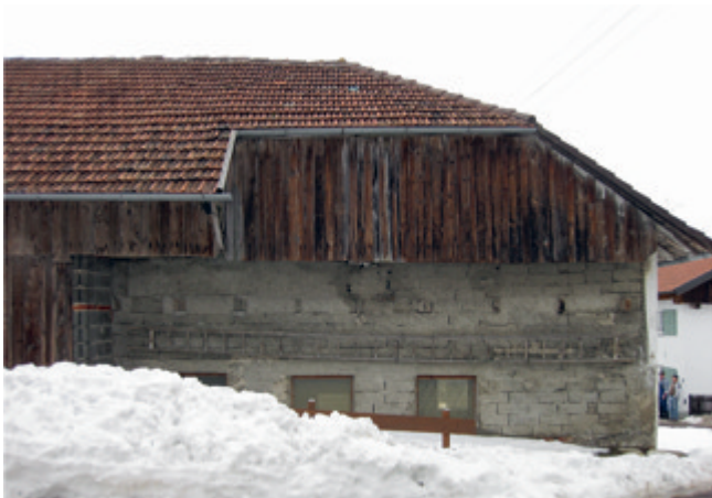
Abb. 30: Ansicht von Osten 2010.
