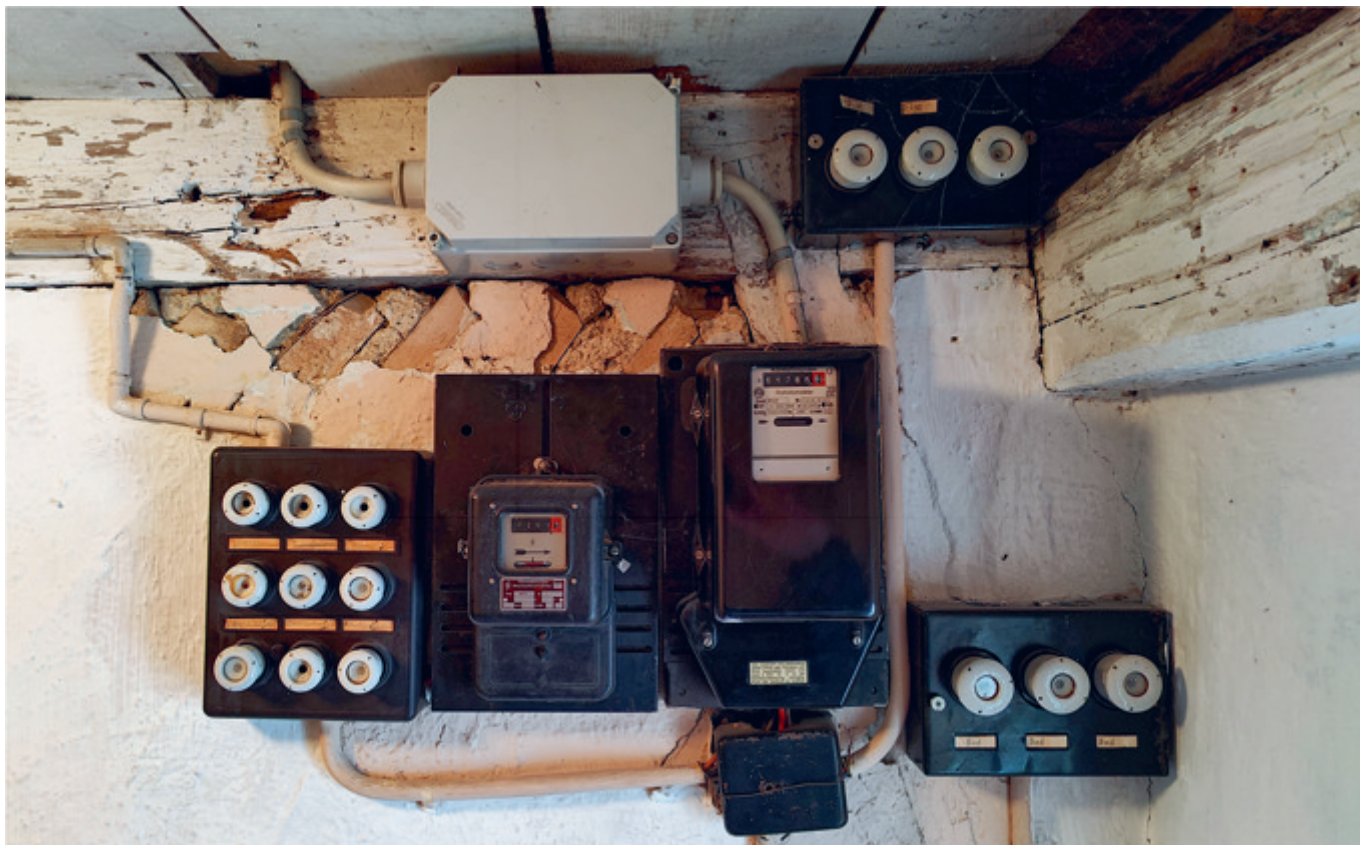
Abb. 24: Historische Elektroinstallationen im Sohler, Zustand 2024.
