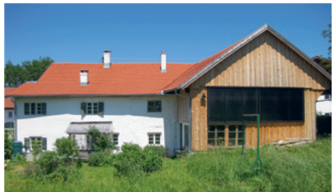
Abb. 33: Ansicht von Süden nach der Sanierung 2013.
