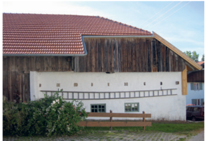
Abb. 31: Ansicht von Osten 2015.
