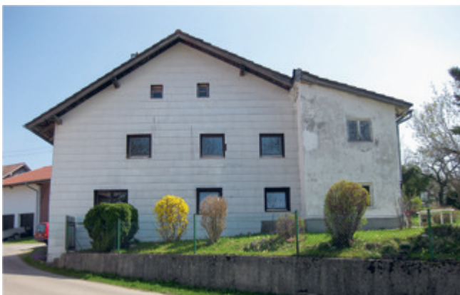
Abb. 34: Ansicht von Westen 2010.
