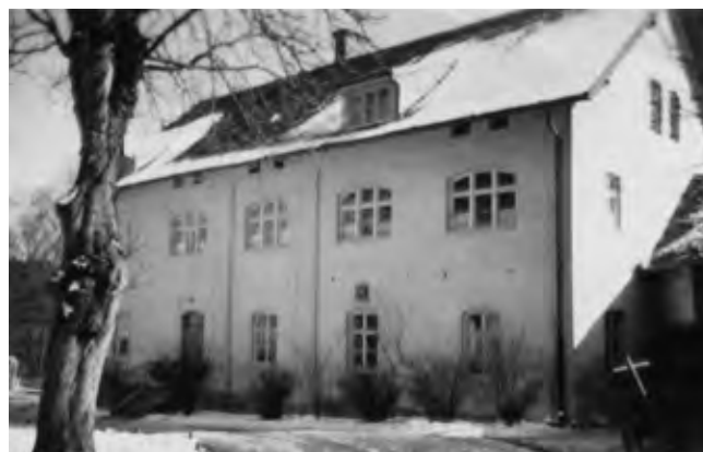
Abb. 18/19: Das Wäschereigebäude der Anstalt (Anfang Juni 1979 abgebrochen).
